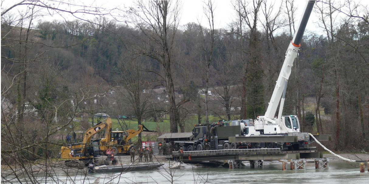
Rückbau des fixen Brückenteils
