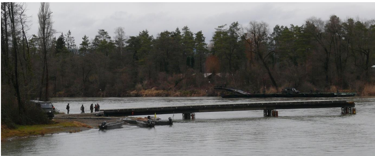
Militärische Brücke über den Rhein mit fixem und schwimmenden Teil (im Hintergrund)
