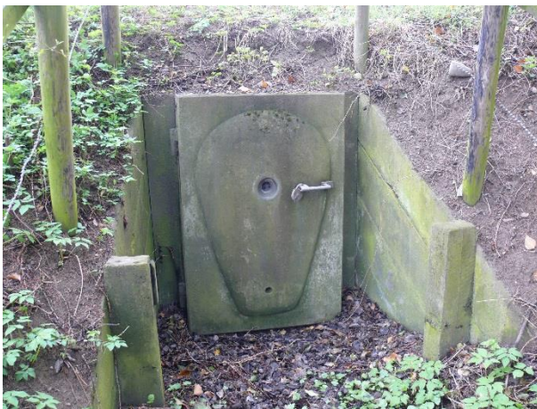
Eingangstüre eines 12 Mann-Unterstandes
