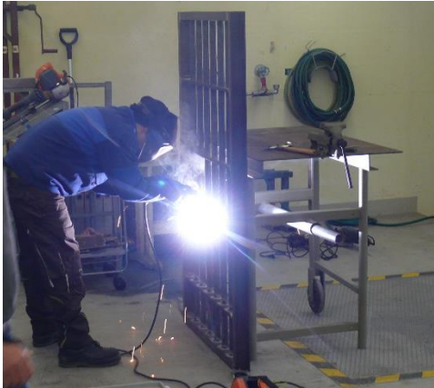
Vorbereiten der Gittertüre in Madetswil
