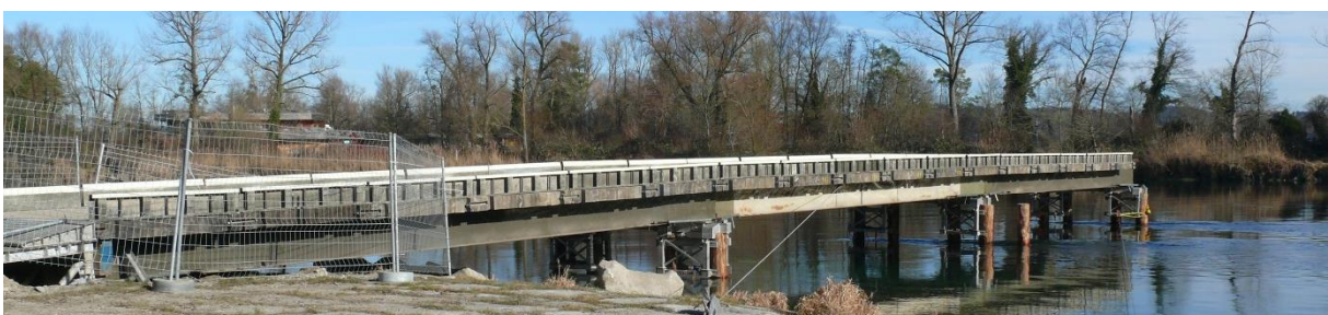
Fixer Brückenteil über den halben Rhein bei Rüdlingen (bei vorbereiteter militärischer Übersetzstelle)
