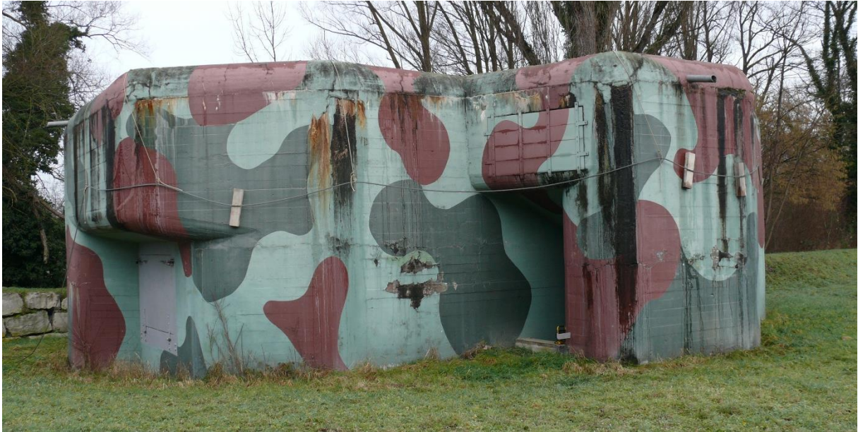
Ausgangslage vor unserer Sanierung der fünfeckigen Kampfanlage
