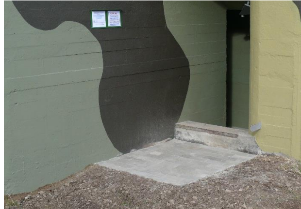
Vorplatz vor dem Eingang zum Bunker
